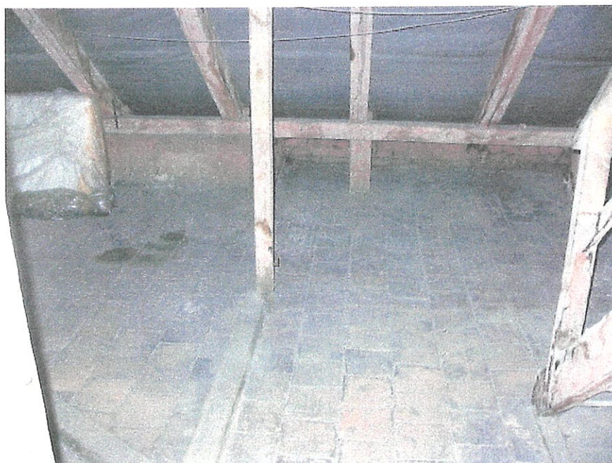
Obr. č.4 pohled na půdní prostory domu
