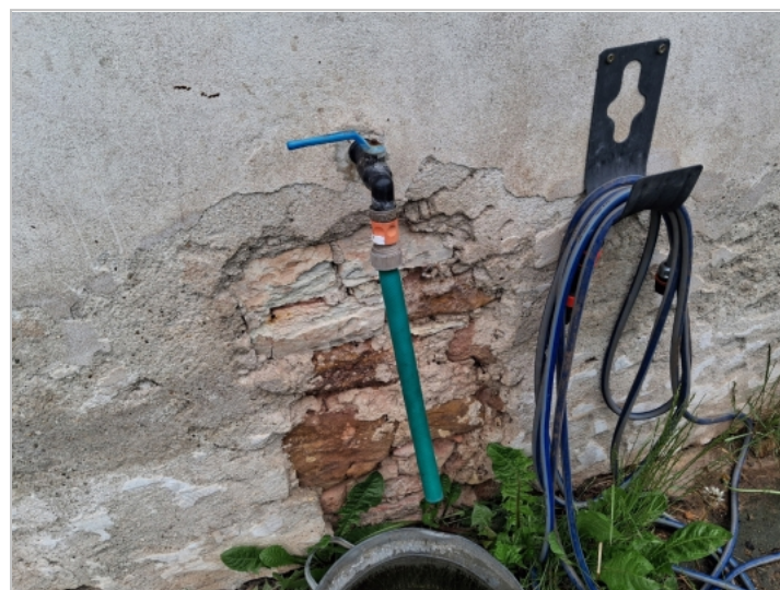
Foto: Sokl jižní fasády
