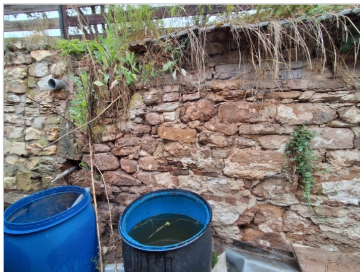
Foto: Opěrná zeď
