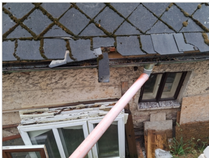
Foto: Odvodnění severní části střechy
