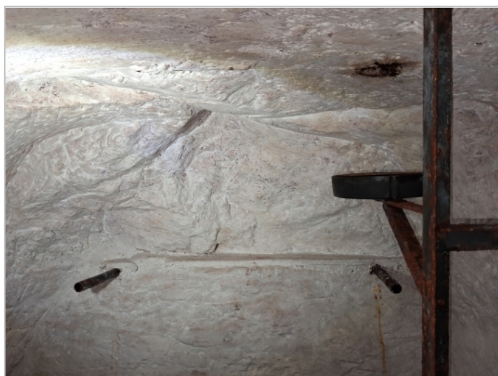
Foto: Tesaná část stropu sklípku
