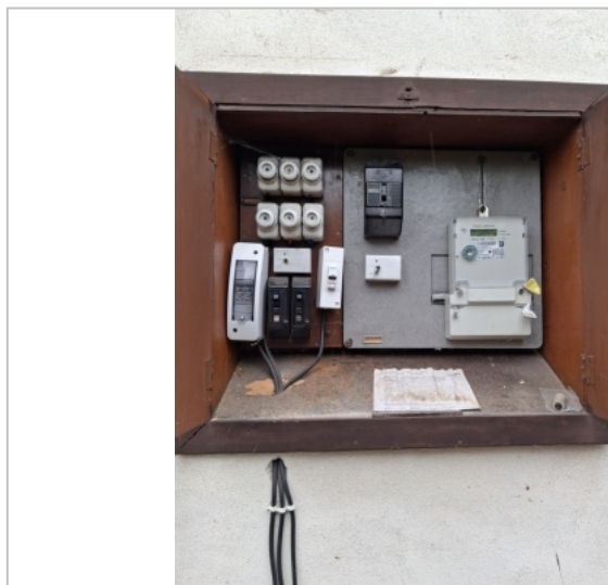
Foto: Elektroměr a původní pojistky
