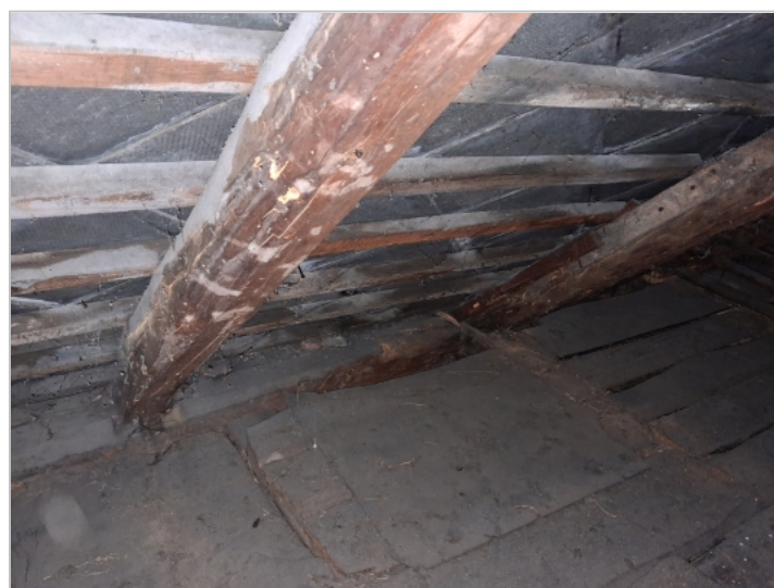
Foto: Spoj krokví a pozednice
