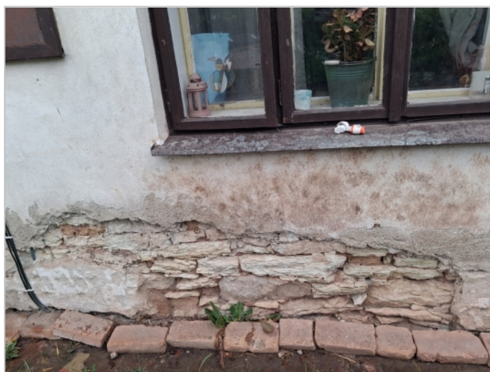
Foto: Sokl jižní fasády
