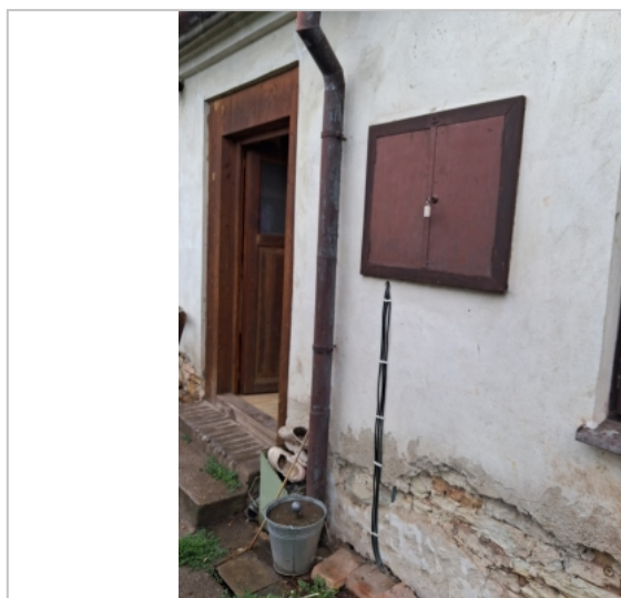
Foto: Sokl jižní fasády
