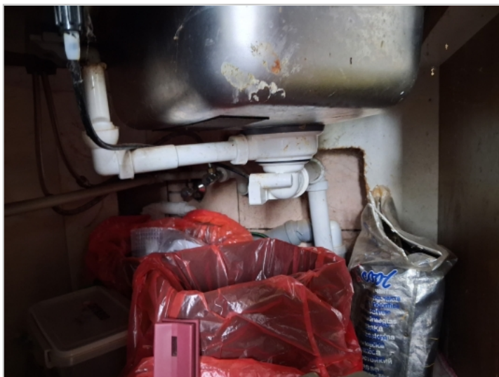
Foto: Napojení odpadu v kuchyni
