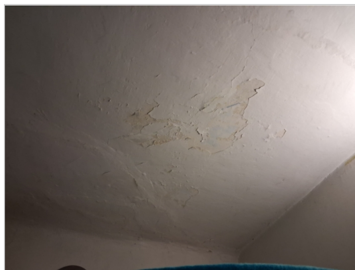
Foto: Strop nad sprchovým koutem
