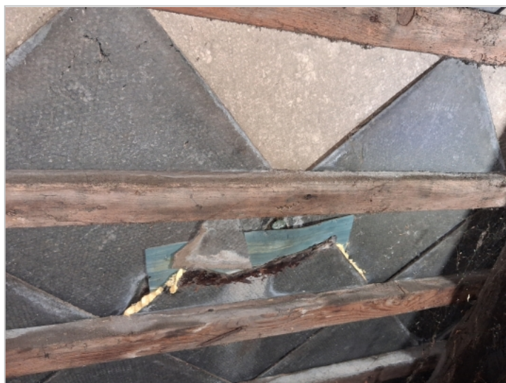
Foto: Oprava krytiny
