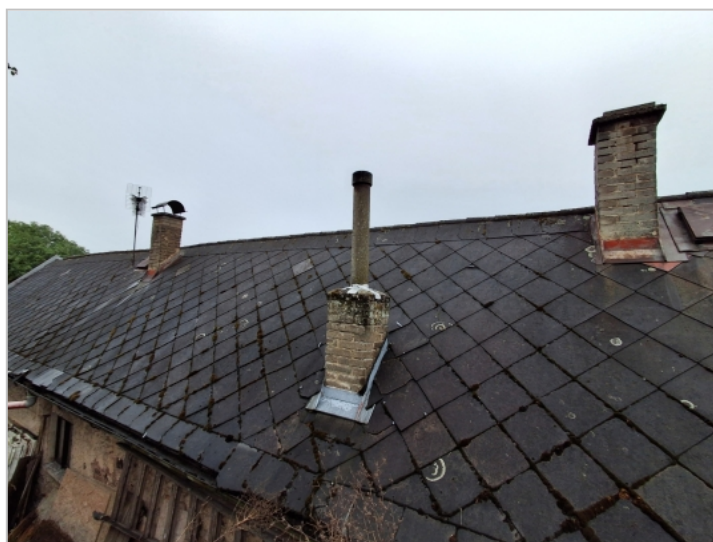
Foto: Zděná komínová tělesa
