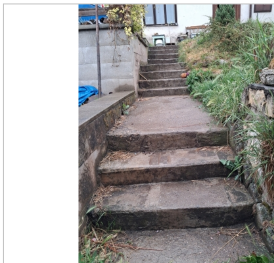
Foto: Venkovní schodiště
