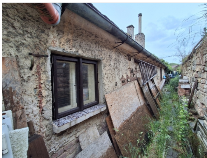
Foto: Keramický obklad parapetu
