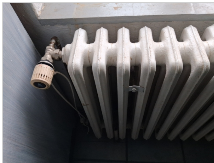
Foto: Otopné těleso s TRV
