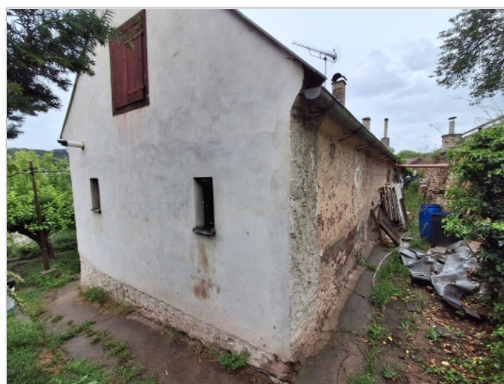
Foto: Severovýchodní pohled
