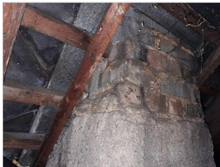
Foto: Dřevěné prvky krovu v těsné blízkosti ko...
