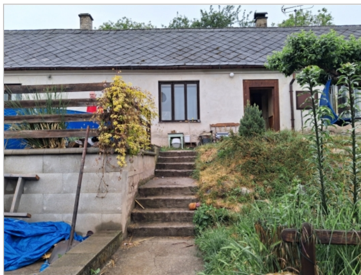
Foto: Venkovní schodiště
