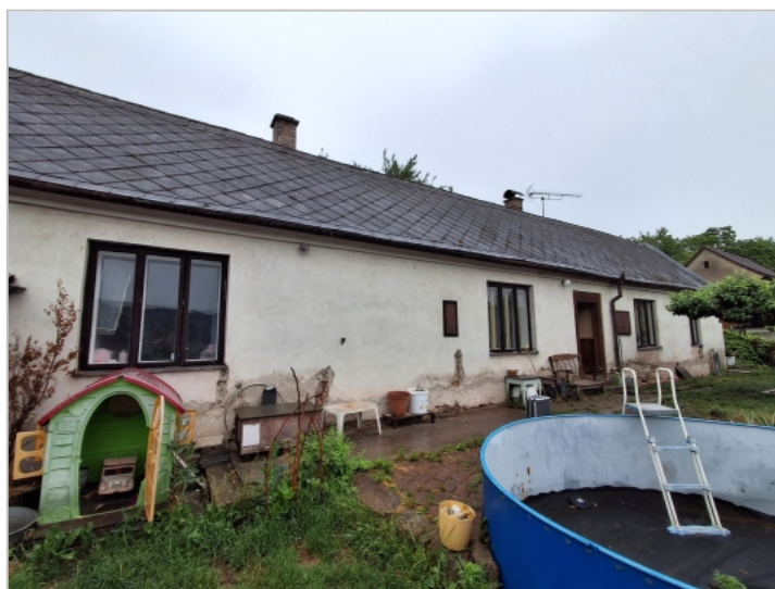
Foto: Jižní pohled
