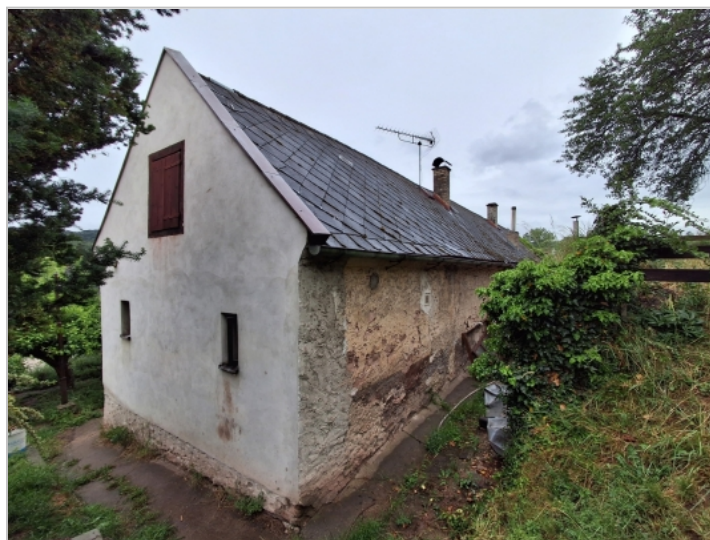
Foto: Severovýchodní pohled
