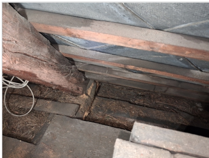
Foto: Vodorovné ztužení vazným trámem
