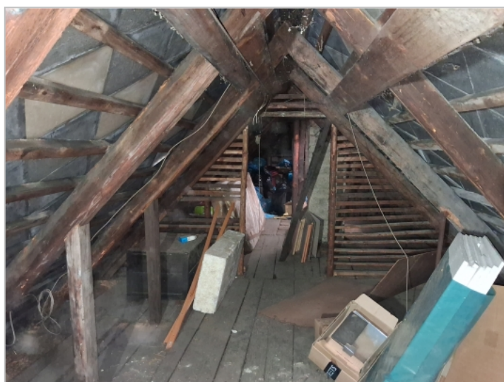
Foto: Konstrukce krovu
