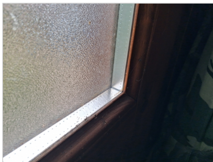
Foto: Zasklení vstupních dveří
