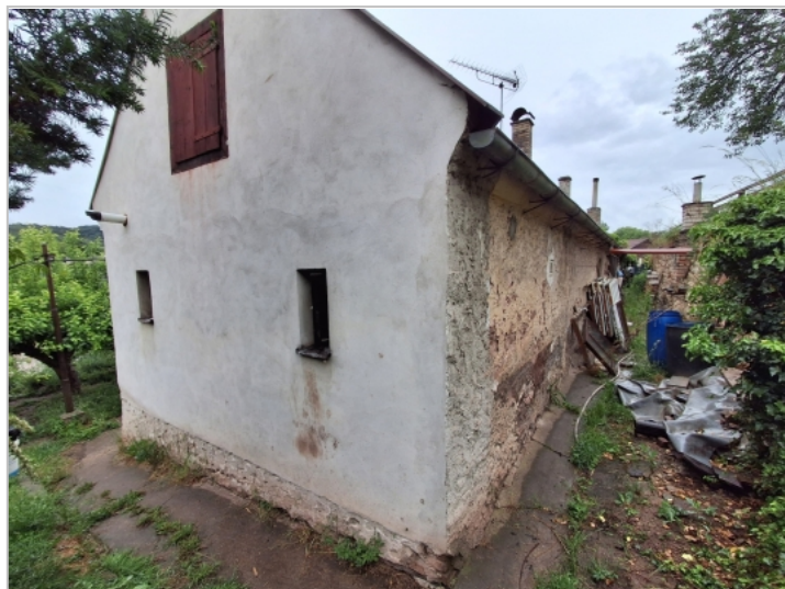
Foto: Severovýchodní pohled
