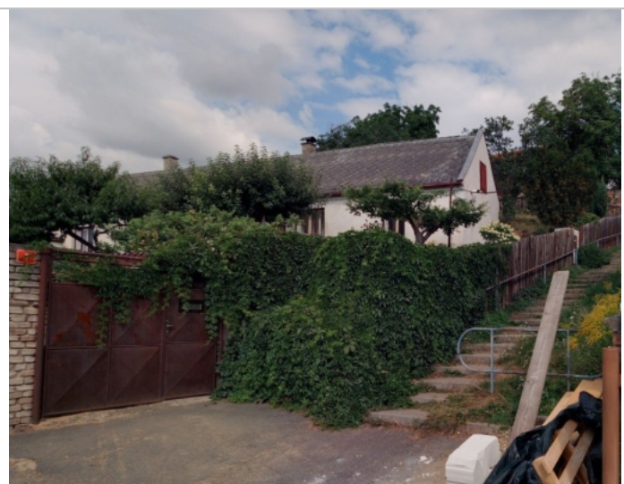
Foto: Pohled z přilehlé komunikace
