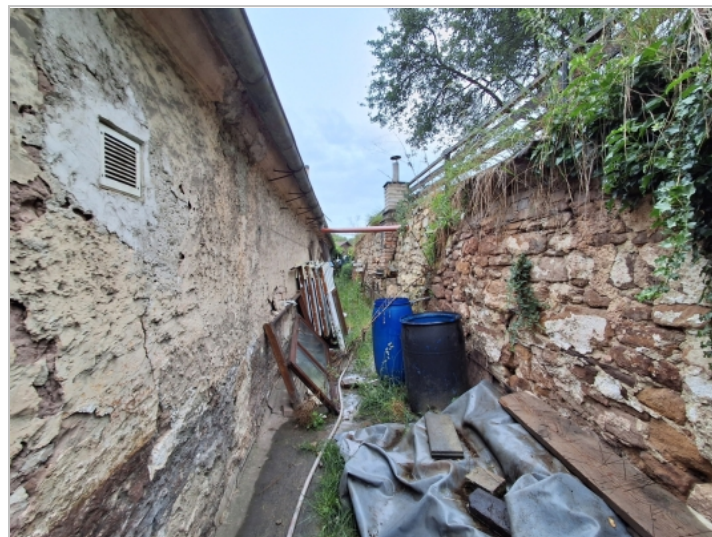
Foto: Opěrná zeď u severní fasády
