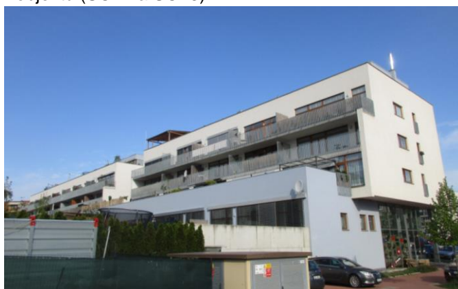
Foto č.3 – jižní fasáda objektu (SO12 a SO13)
