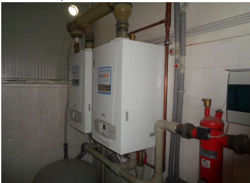
Obrázek č. 4.1.6: Plynové kotle
