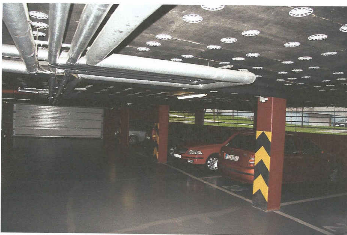
Garáže pod objektem
